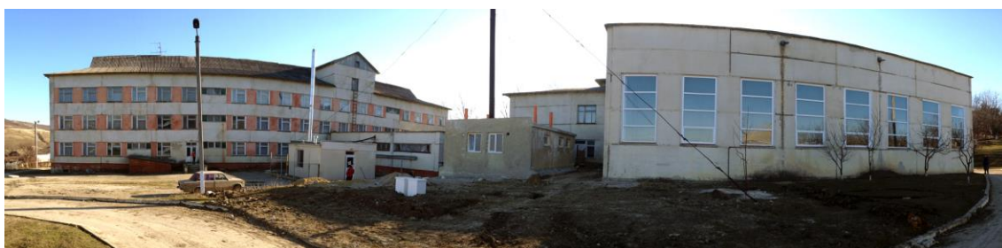
Figura 6-3: Vedere panoramică; blocul A, centrala termică, B, WC, V 2 vedere din partea de est
