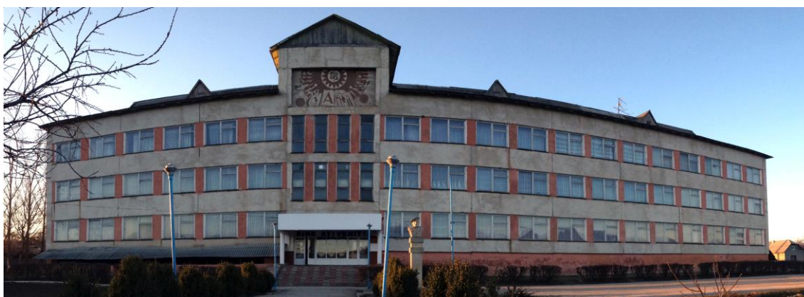
Figura 6-2: Vedere panoramică; blocul A, intrarea principală; vederea din partea de sud
