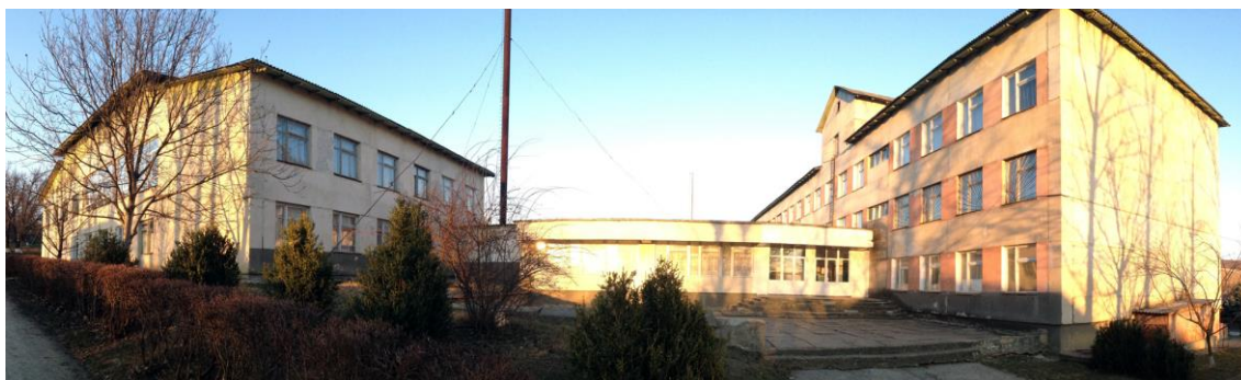
Figura 6-4: Vedere panoramică; blocul V 1 , B, A; vederea din partea de vest
