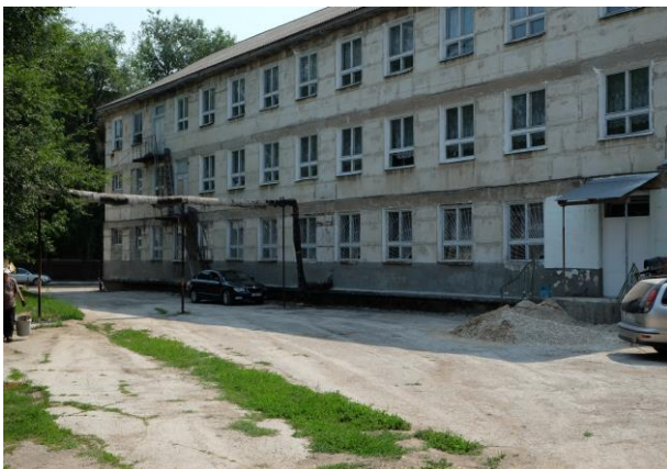
Figura 6-4: Blocul A 3 , vedere din partea de vest, 3 nivele (săli de clasă)
