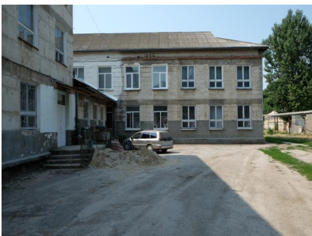
Figura 6-6: Blocul A—aripa de nord-est, vedere din partea nord-est, 2 nivele (săli de clasă)
