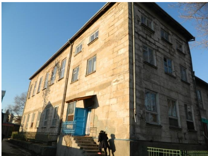
Figura 6-7: Blocul A, aripa de sud-vest cu trei nivele, vedere din partea de sud, acces la bucătărie
